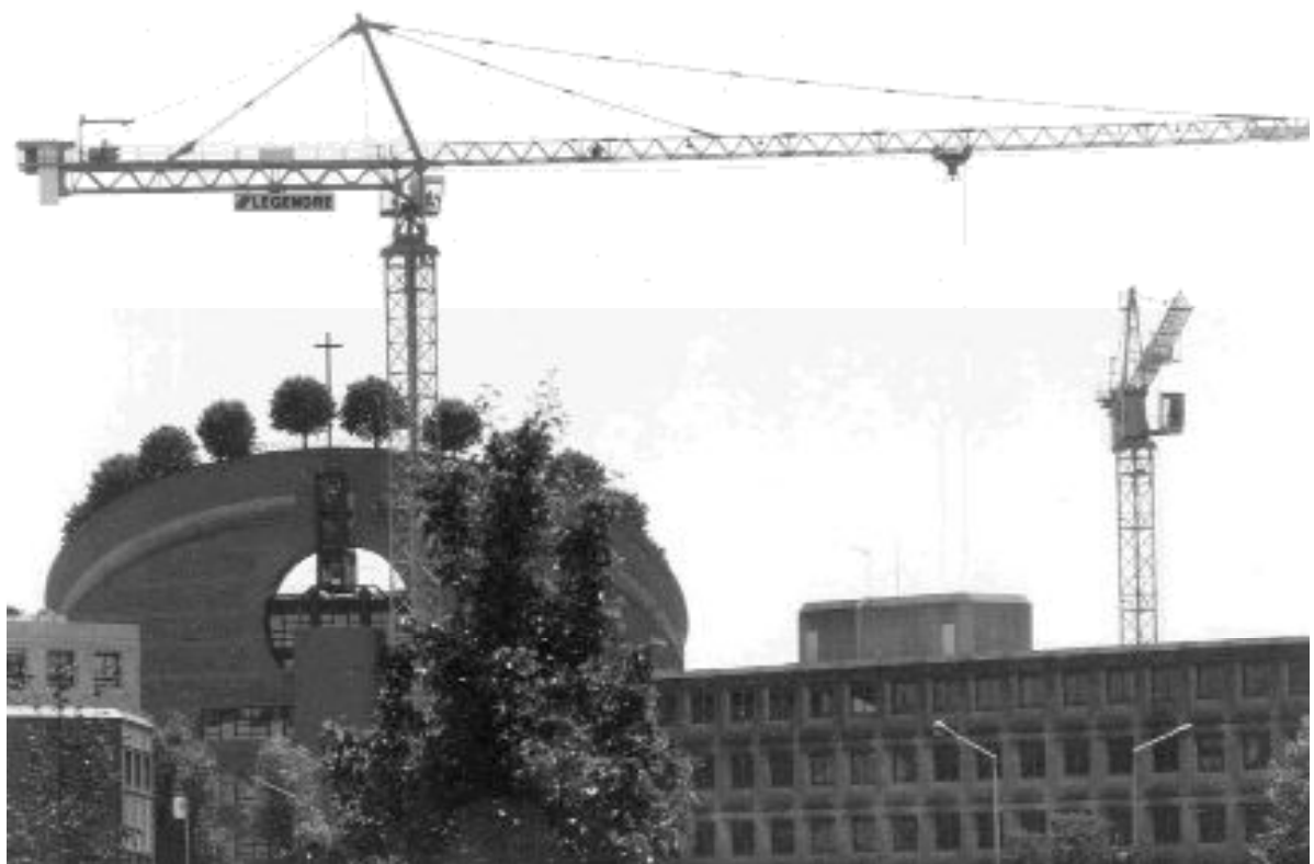
La cathédrale et la mosquée construites au cœur de la ville nouvelle d'Evry, en région parisienne.
